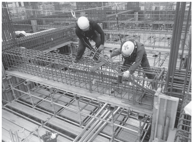
↑梁にセットした管内にPC鋼より線を挿入
